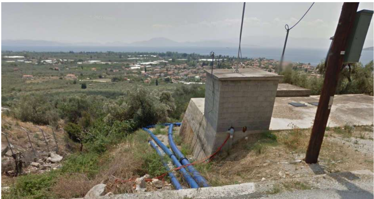
Φωτογραφία 8: Δεξαμενή Σπαστήρα Αγριάς παλιά κατάντη του δρόμου
