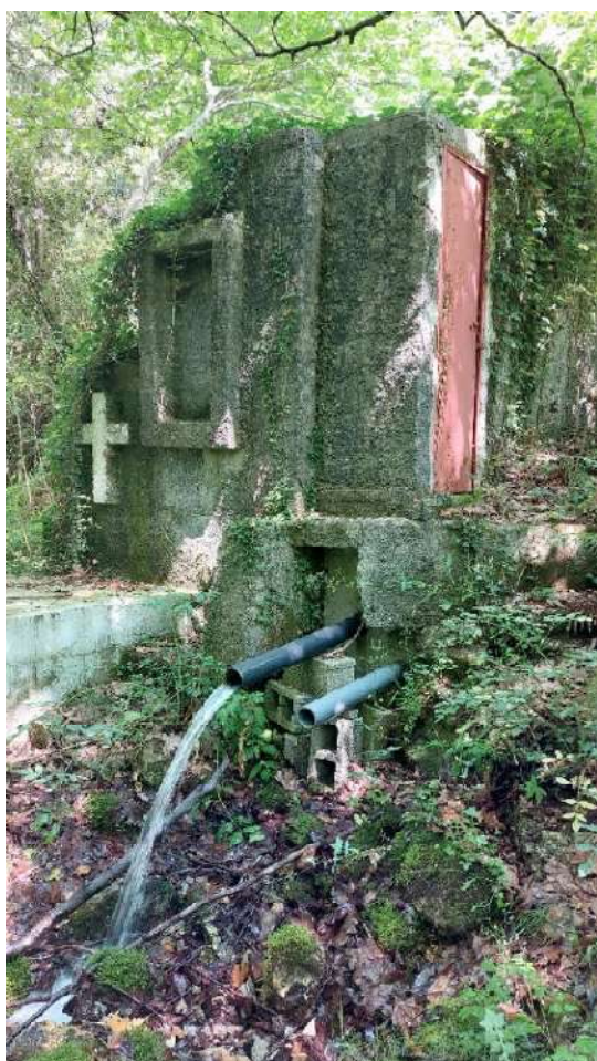
Φωτογραφία 4: Φρεάτιο υδρομάστευσης πηγής Ζάγκα (εξωτερικά αριστερά και εσωτερικά δεξιά)
